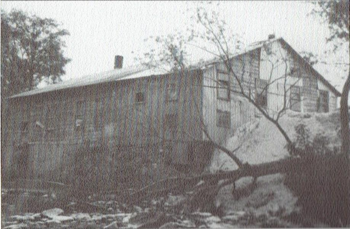
Manufacture de Viateur Lussier. La partie de gauche correspond à l'emplacement de la Fonderie Milton et les fondations, en pierres, sans doute les mêmes depuis le début, reposaient directement dans le lit de la rivière Mawcook dont on voit les rapides en avant-plan. Le moulin à farine (partie de droite où la couverture est plus pâle) a été ajouté vers 1950. À noter à droite le gros tas de bran de scie, expulsé par une soufflerie, résultant des opérations de la manufacture. (Photo Album 150°, collection Maison Vittie)
